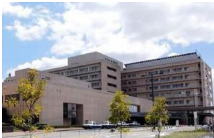
【半田病院／愛知県半田市】
