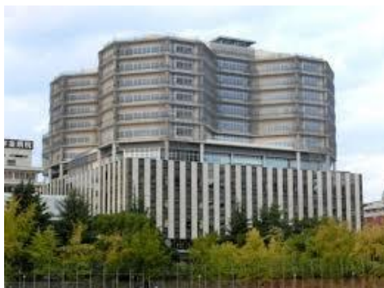
【JCHO大阪病院外観(大阪府大阪市)】
