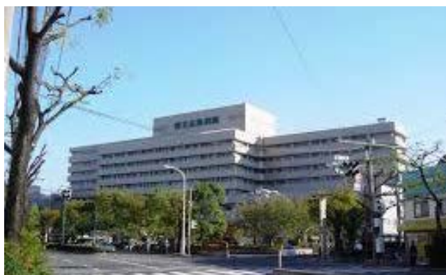
【県立広島病院(広島県広島市)】
